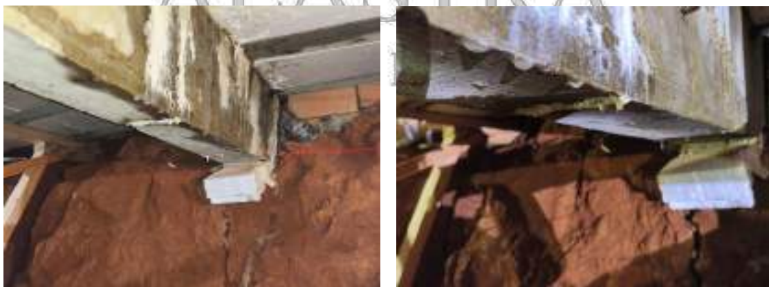
Imagem 3 e 4: Infiltração de Águas pluviais em elementos estruturais. Fonte autor
