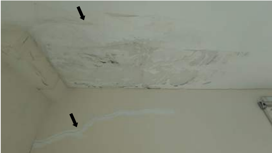
Figura 15 – Sinais de umidade no teto e trinca na parede da Sala 2.
