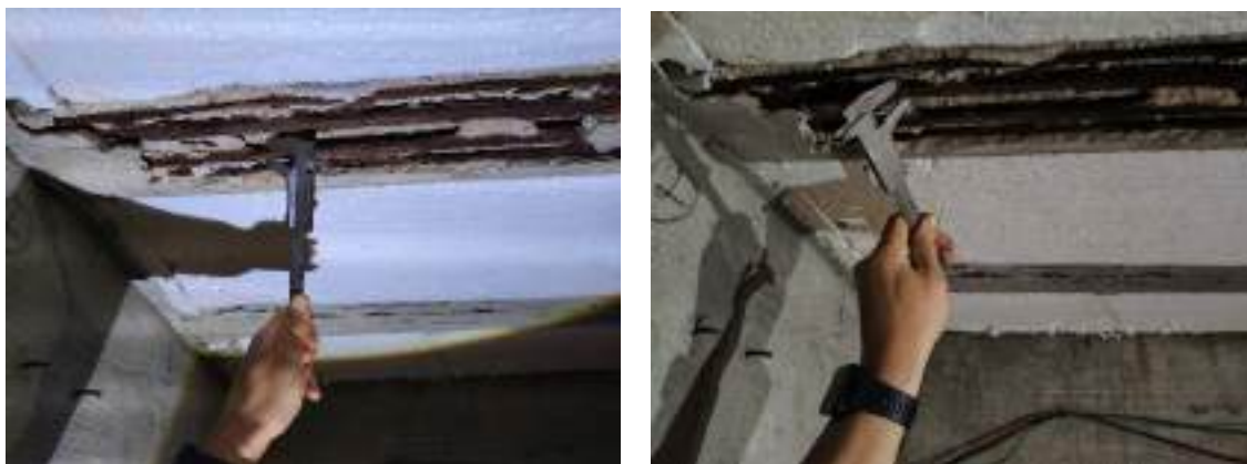
Imagens 9 e 10: Identificação bitola de aço lajes. Fonte autor
