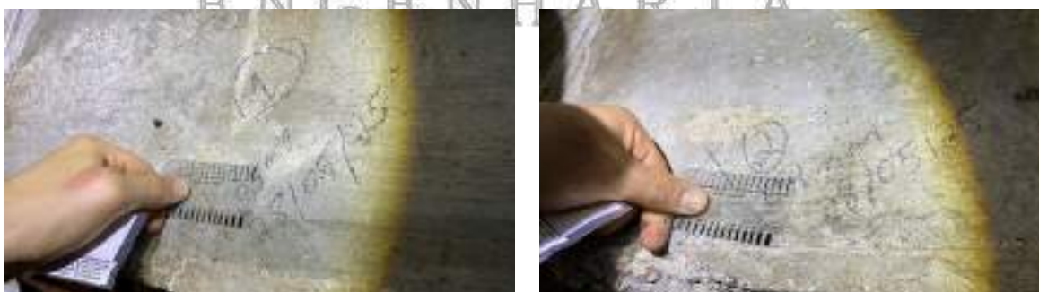
Imagens 7 e 8: Exemplo Viga: V58. Fonte autor
