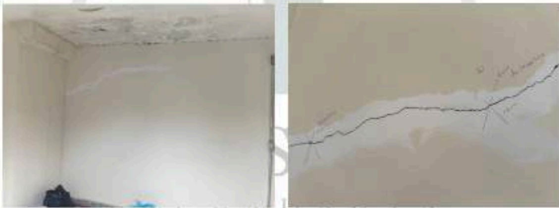
Imagem 5 e 6 (dia 06/02/2026): Nova fissura identificada fora do objeto principal do monitoramento. Fonte autor
