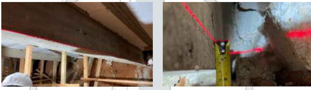
Imagens 5 e 6: Exemplo Viga: V46. Fonte autor
