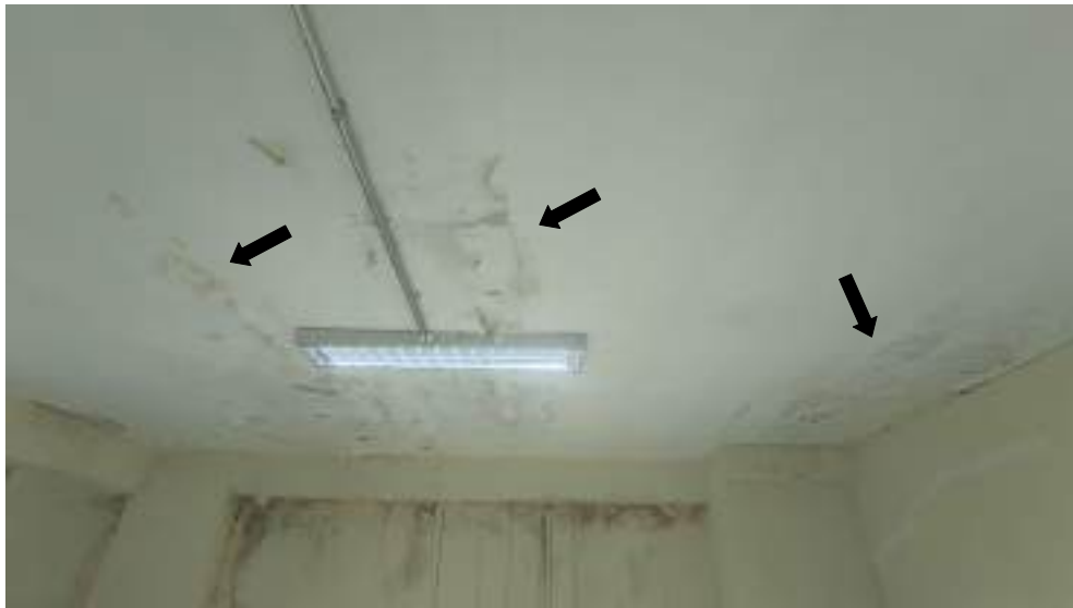
Figura 17 – Sinais de umidade no teto e nas paredes da Sala 2.
