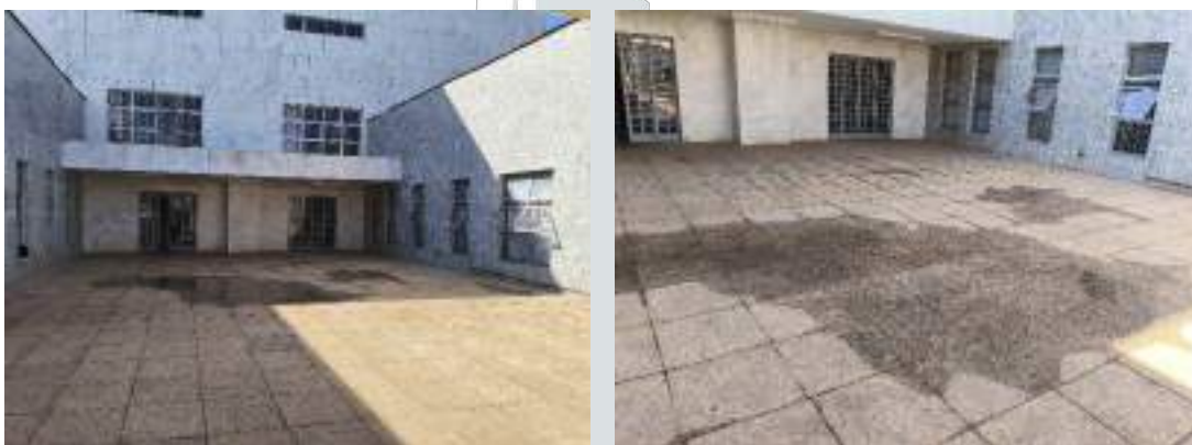
Imagem 1 e 2 - visita anterior: Empoçamento de águas pluviais L4A e L5A. Fonte autor
