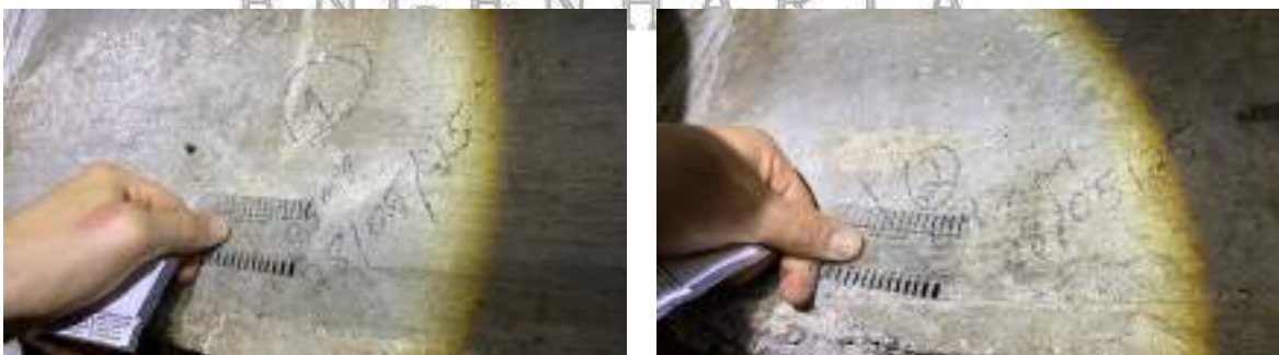
Imagens 7 e 8: Exemplo Viga: V58. Fonte autor
