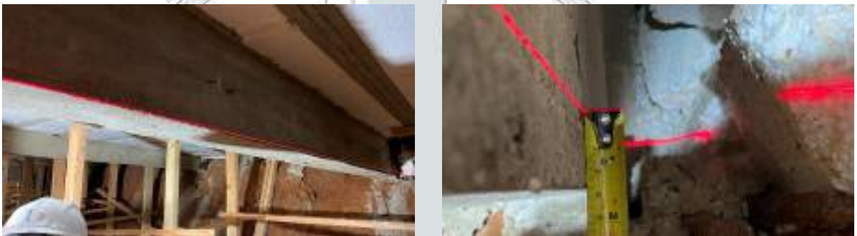
Imagens 5 e 6: Exemplo Viga: V46. Fonte autor
