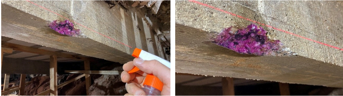
Imagens 17 e 18: Exemplo Viga: V77. Fonte autor
