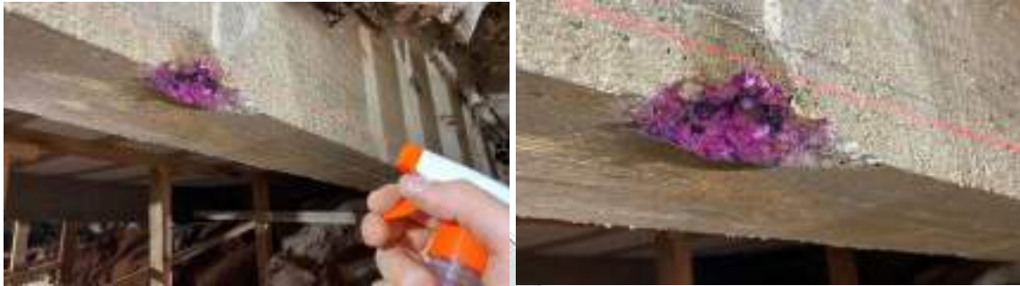
Imagens 9 e 10: Exemplo Viga: V77. Fonte autor
