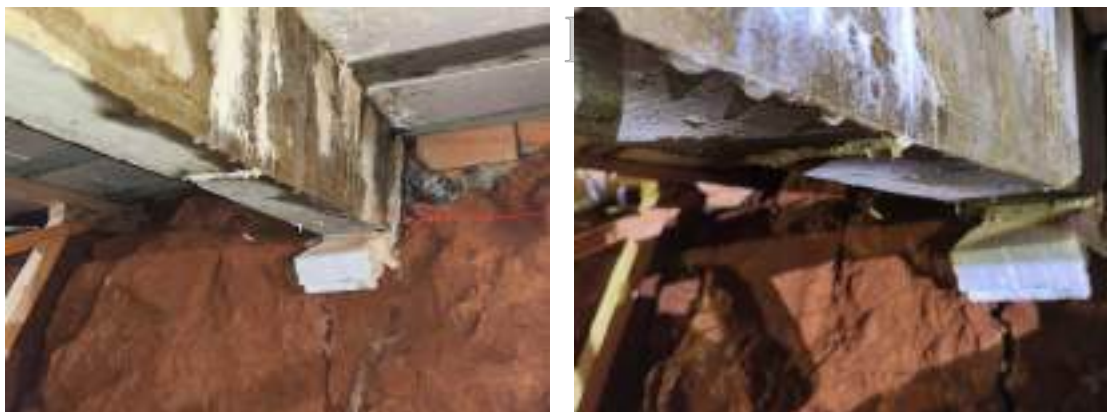
Imagem 3 e 4 (visitas anteriores): Infiltração de Águas pluviais em elementos estruturais. Fonte autor
