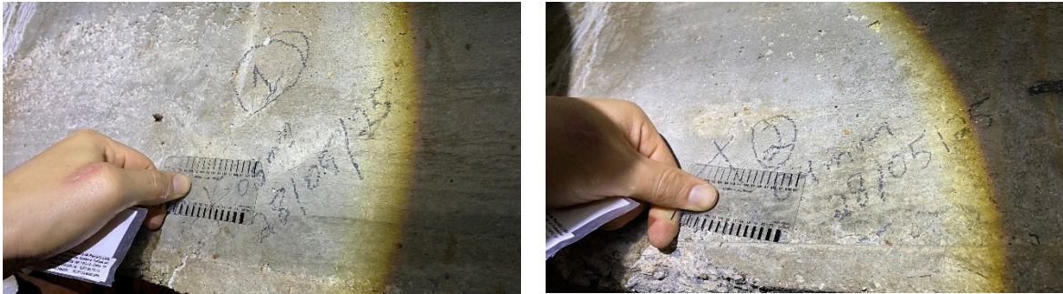
Imagens 13 e 14: Exemplo Viga: V58. Fonte autor
