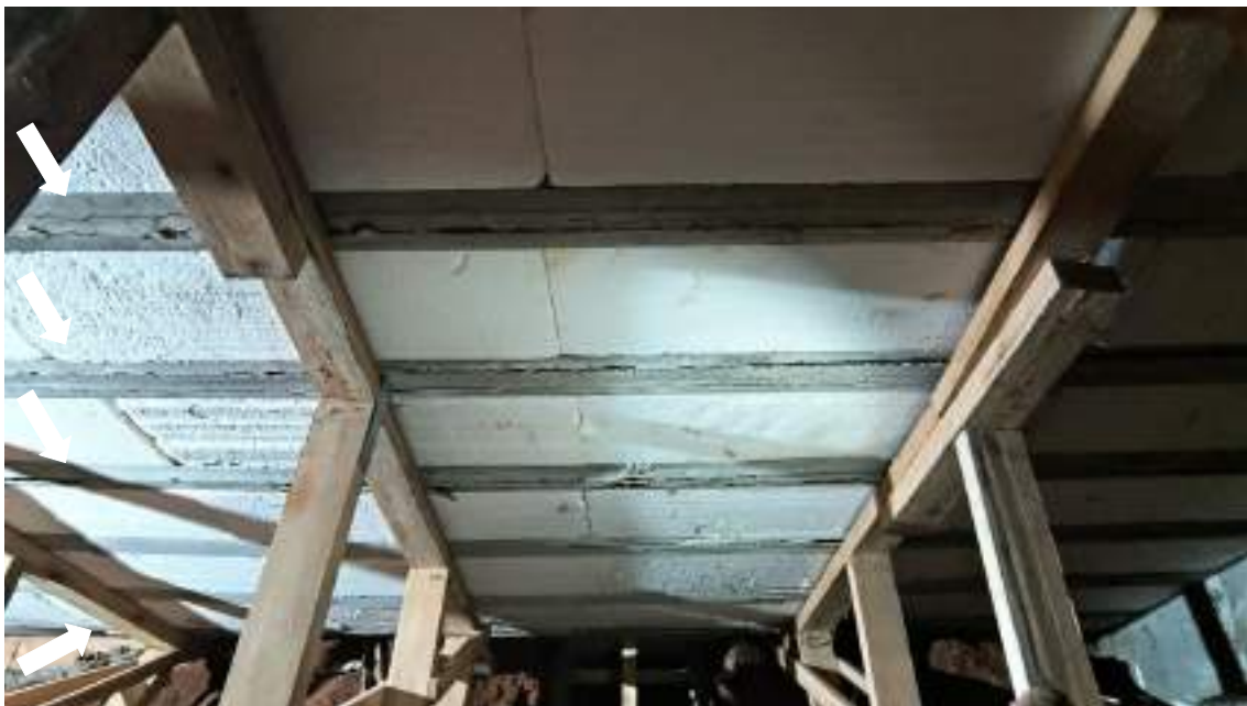
Figura 30 – Deformação e deterioração da laje.
