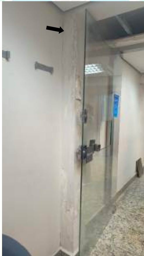
Figura 12 – Sinais de umidade na parede da Sala 1.
