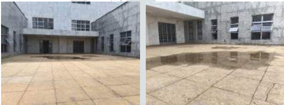
Imagem 1 e 2 Nesta data: Empoçamento de águas pluviais L4A e L5A. Fonte autor
