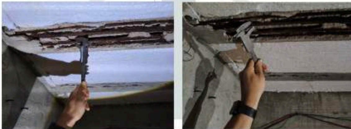
Imagens 11 e 12: Identificação bitola de aço lajes. Fonte autor
