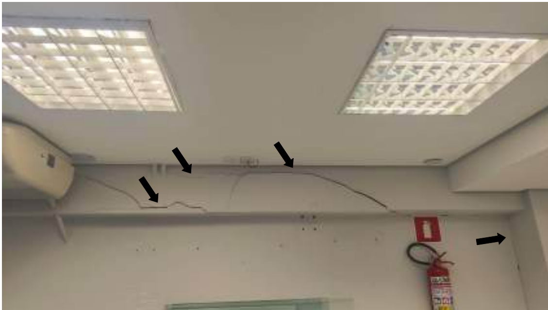
Figura 11 – Rachaduras e trincas na parede da sala 1.
