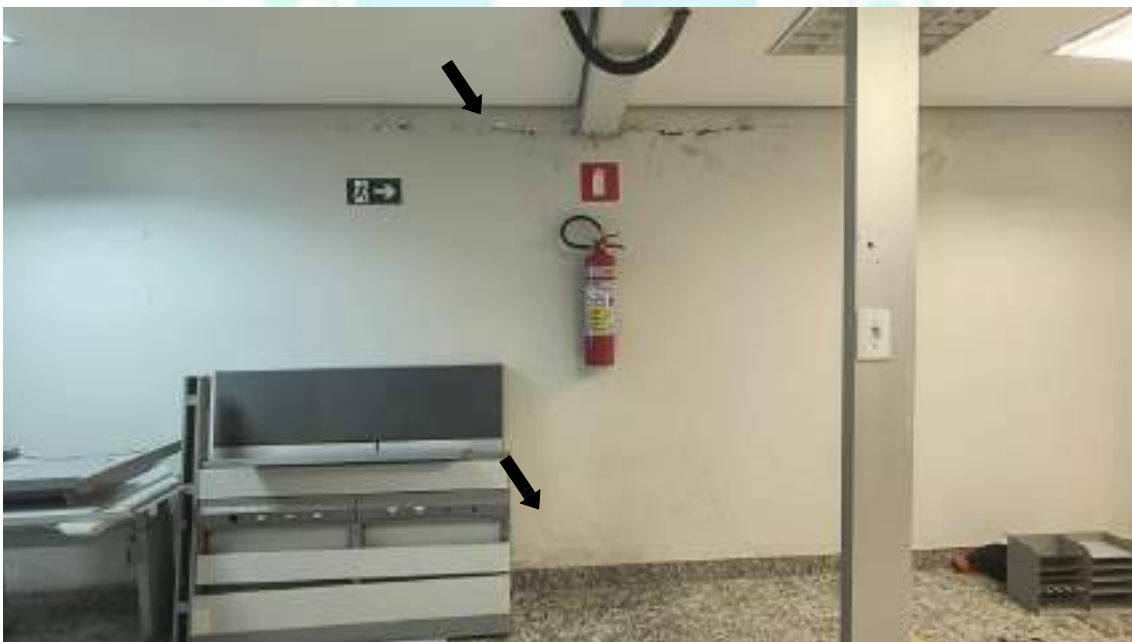
Figura 10 – Sinais de umidade na parede da Sala 1.
