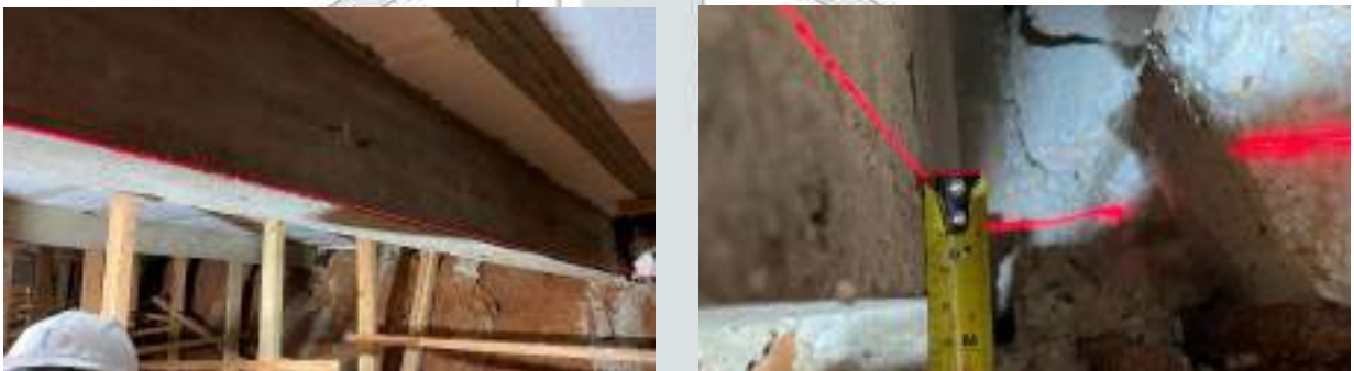
Imagens 5 e 6: Exemplo Viga: V46. Fonte autor
