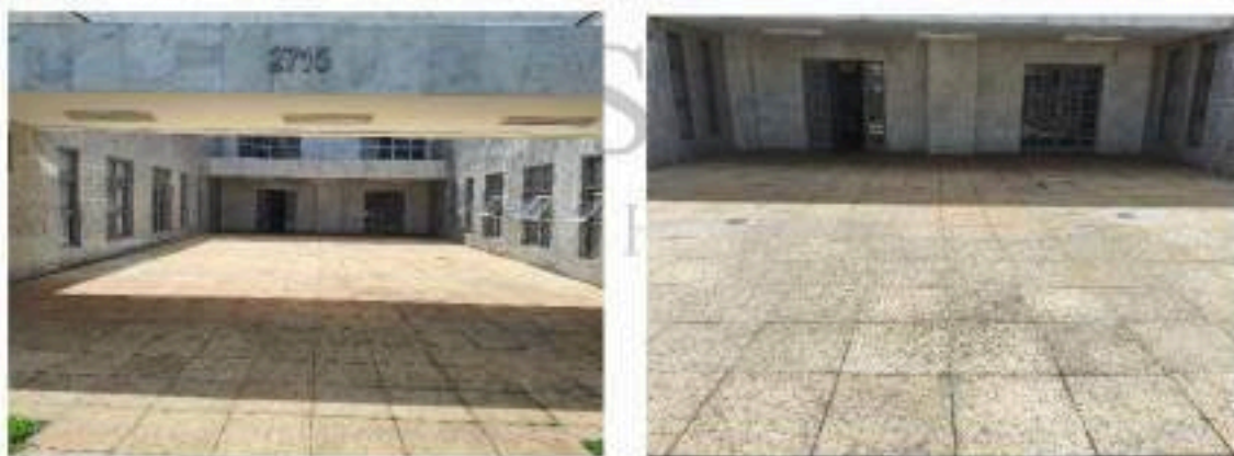
Imagem 1 e 2 (dia 06/02/2026): Sistema provisório captação água nas lajes L4A e L5A. Fonte autor
