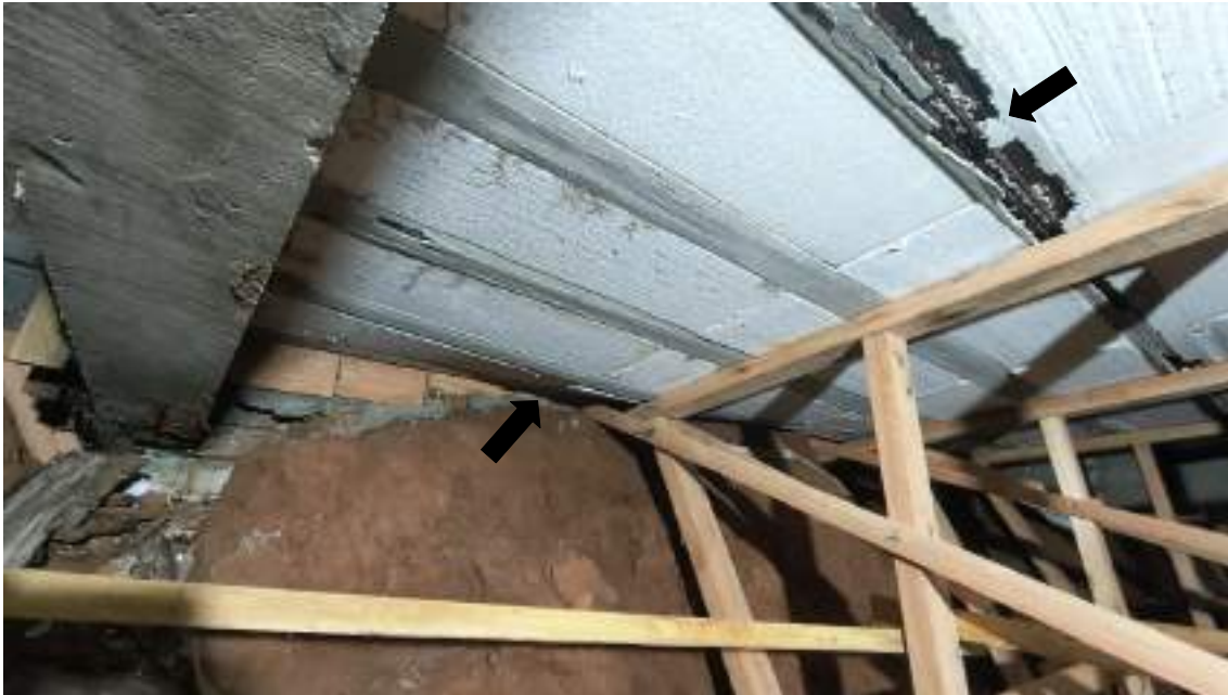
Figura 25 – Deformação na laje e corrosão nas armaduras.
