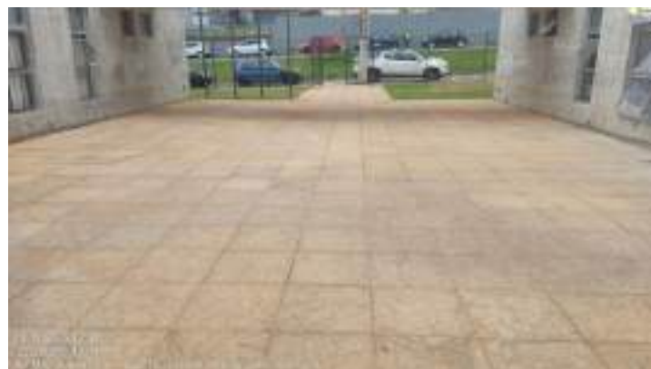
Figura 2 – Laje com risco.
