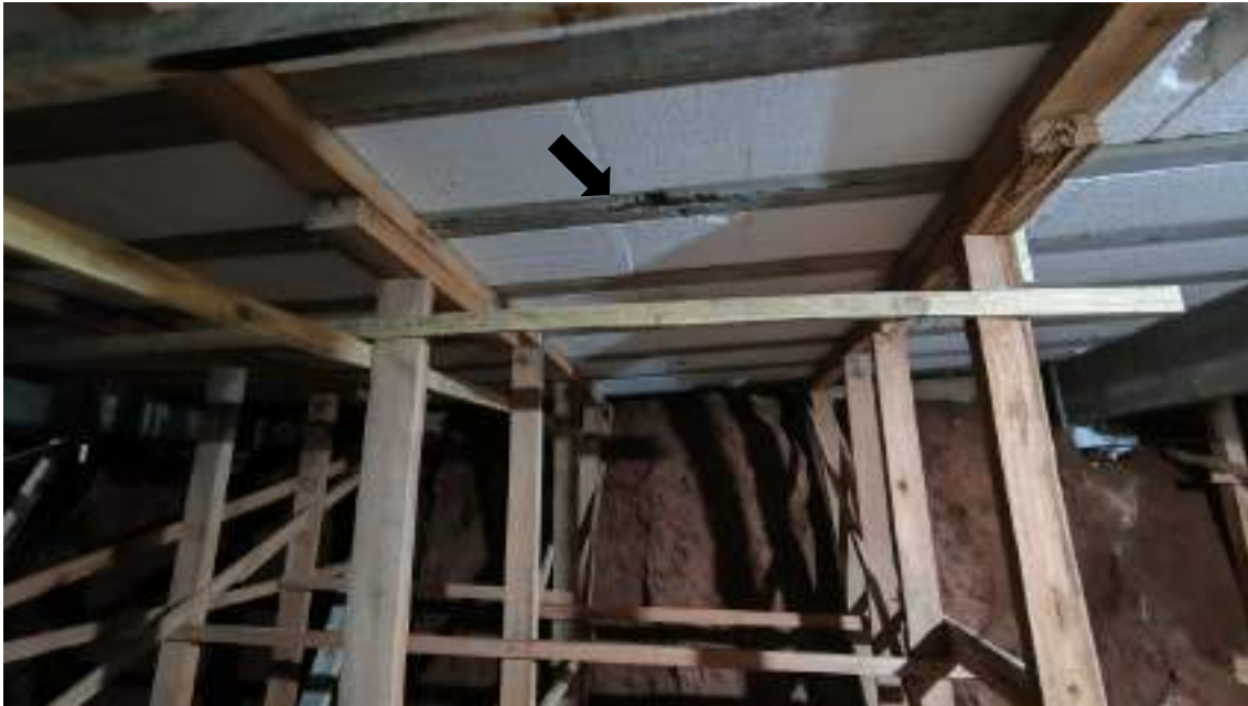
Figura 23 – Deterioração da laje.
