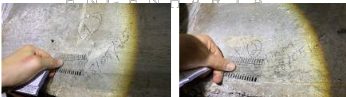
Imagens 7 e 8: Exemplo Viga: V58. Fonte autor
