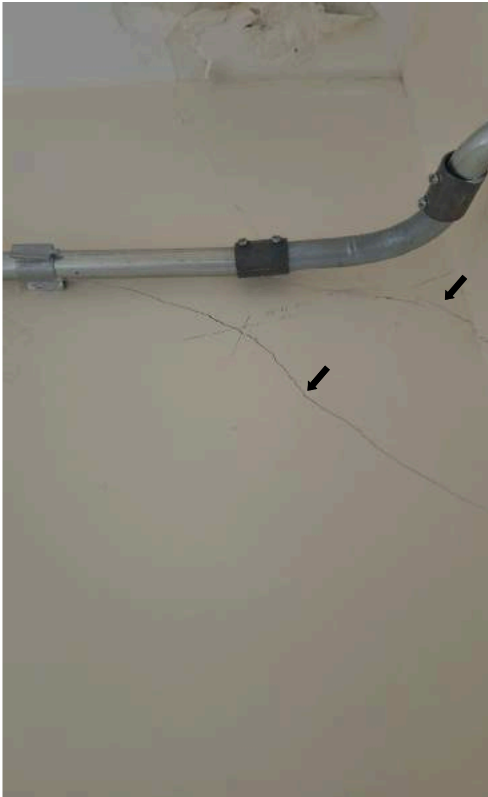
Figura 20 – Trinca na parede da Sala 2.
