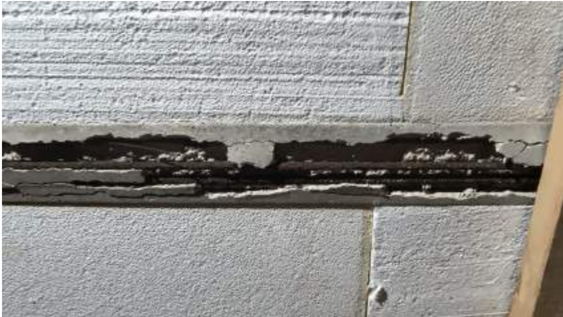
Figura 29 – Corrosão das armaduras.
