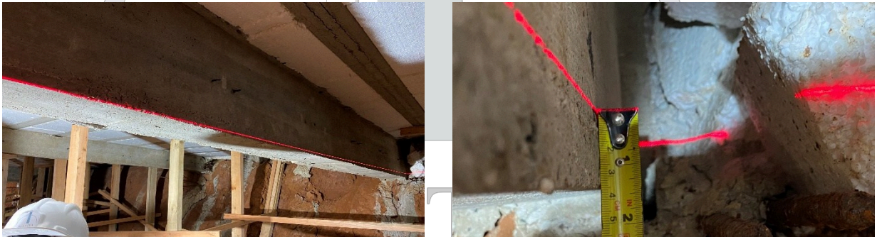
Imagens 11 e 12: Exemplo Viga: V46. Fonte autor
