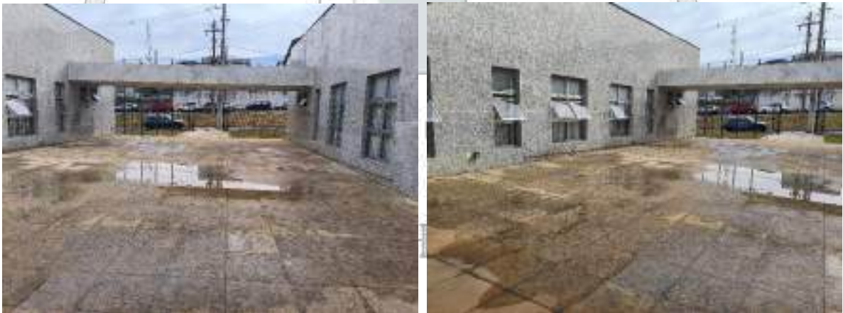
Imagem 3 e 4: Empoçamento de águas pluviais L4A e L5A. Fonte autor
