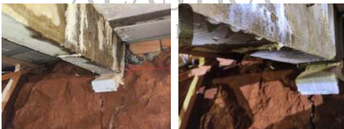
Imagem 3 e 4 (visita anterior): Infiltração de Águas pluviais em elementos estruturais. Fonte autor
