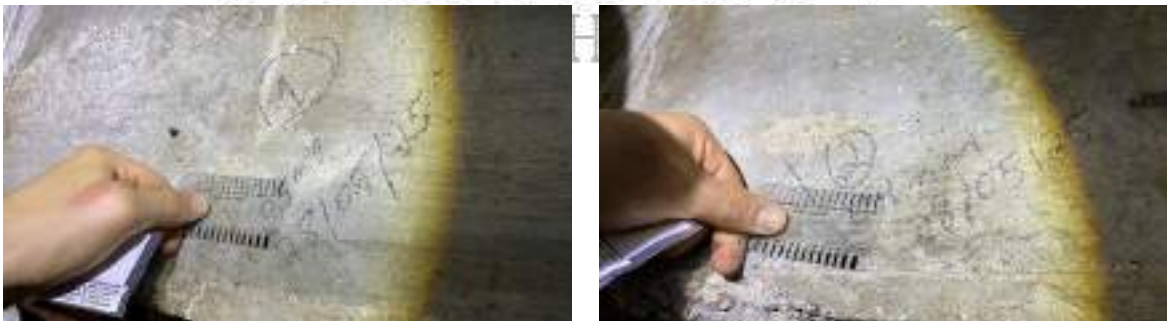
Imagens 7 e 8: Exemplo Viga: V58. Fonte autor
