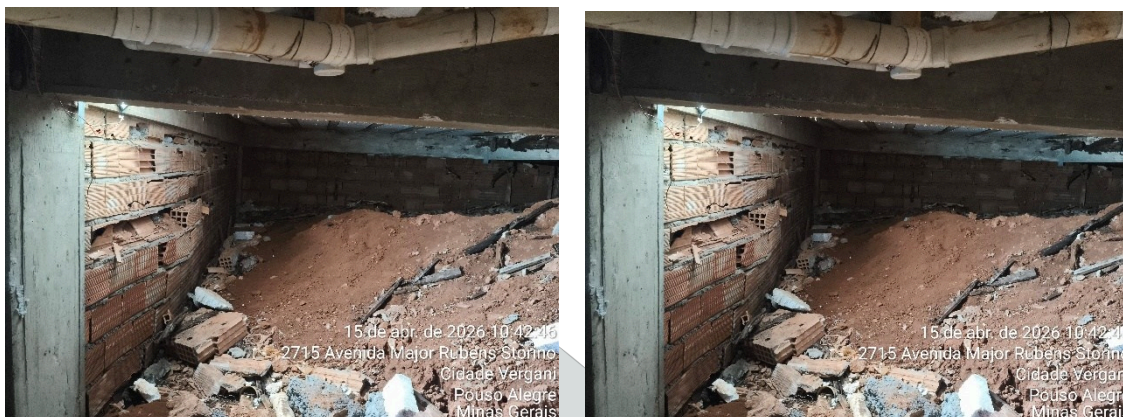
Imagem 09 e 10 (dia 15/04/2026): Alvenaria para contenção de solo com patologias. Fonte autor
