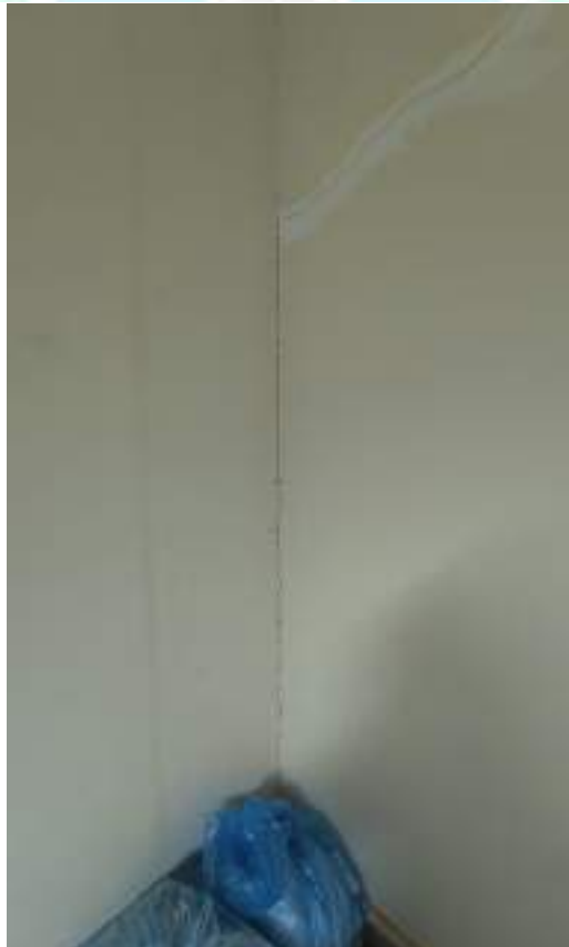
Figura 16 – Trinca no encontro das paredes, na Sala 2
