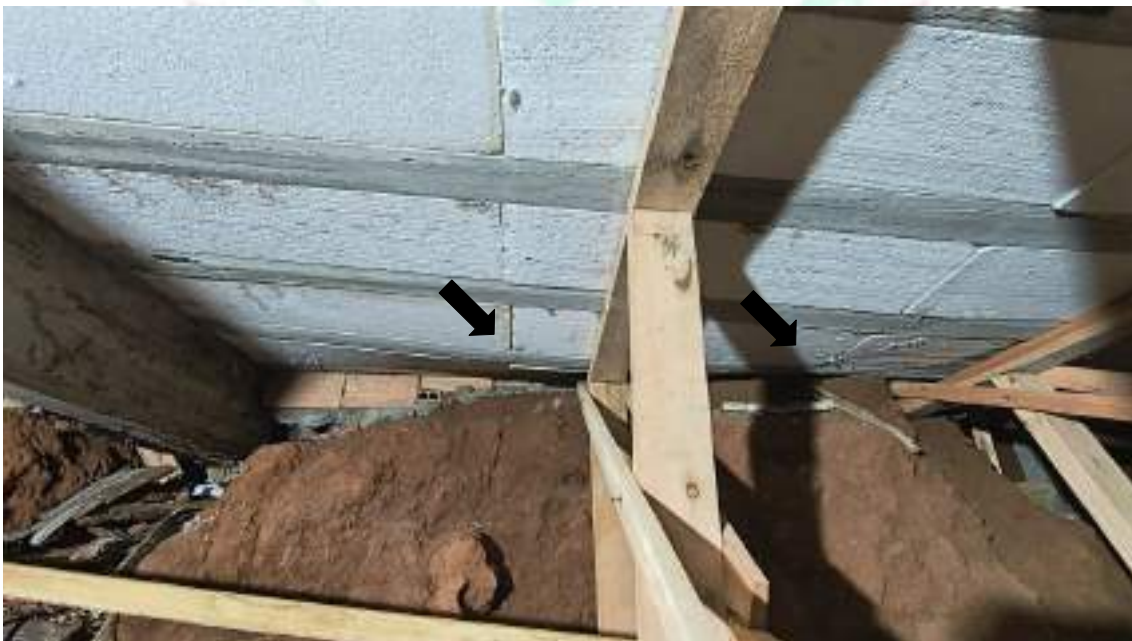
Figura 24 – Deformação na laje.
