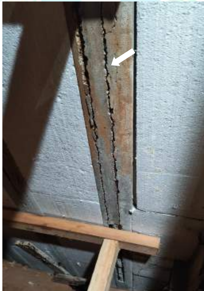
Figura 28 – Deterioração da laje.
