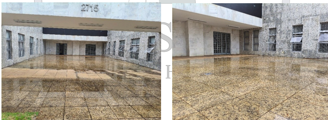
Imagem 1 e 2 (dia 10/03/2026): Sistema provisório captação água nas lajes L4A e L5A. Fonte autor
