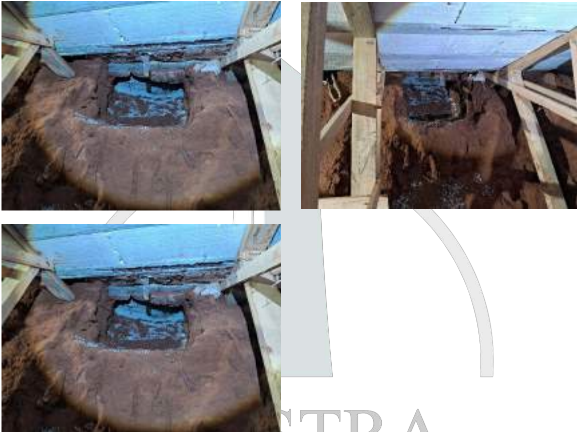
Fotos 1,2 e 3: escavação apoio L5A. Fonte Autor
