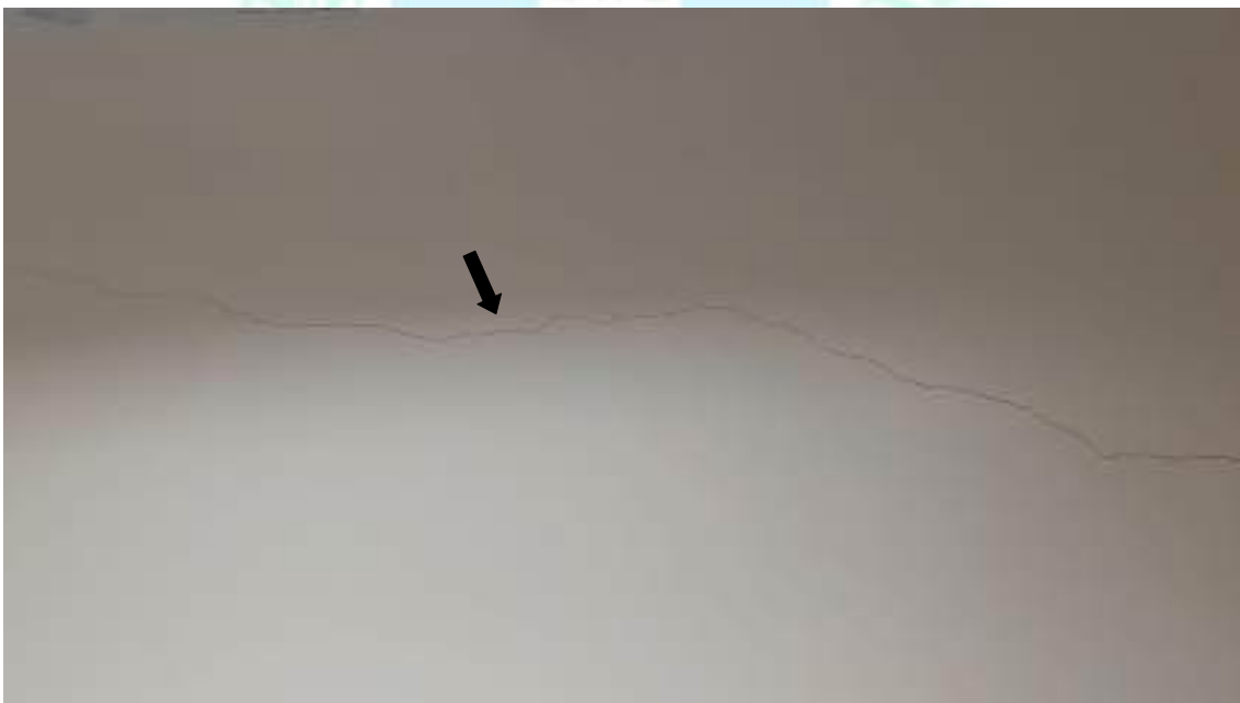
Figura 6 – Trinca horizontal na parede do corredor, no pavimento inferior ao térreo.
