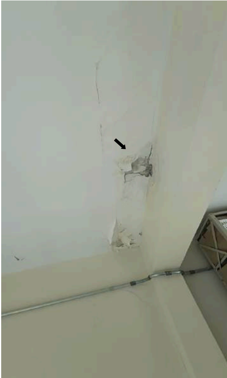
Figura 21 – Sinais de umidade na parede da Sala 2.
