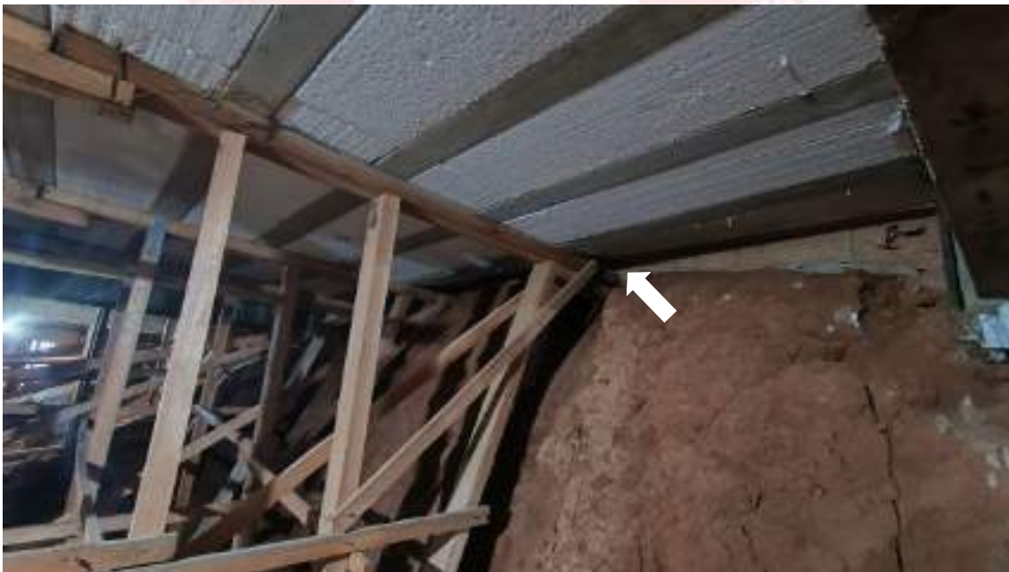
Figura 26 – Deformação na laje.
