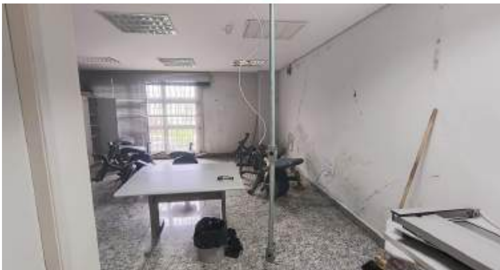
Figura 8 – Sala 1 com sinais de umidade nas partes inferiores e superiores da parede.
