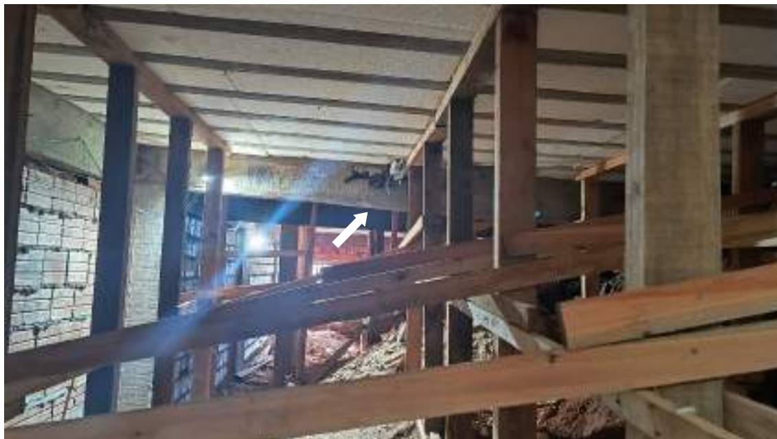
Figura 31 – Indícios de início de deformação na viga.
