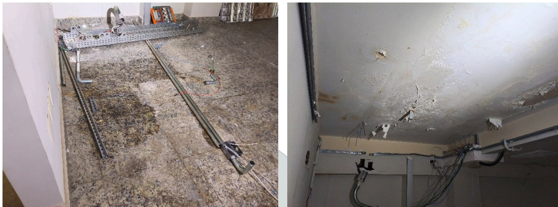
Imagem 07 e 08 (dia 10/03/2026): diversos pontos com infiltração, fora do objeto estrutural principal. Fonte autor
