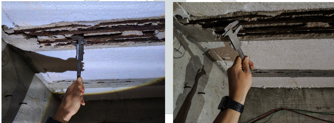
Imagens 15 e 16: Identificação bitola de aço lajes. Fonte autor
