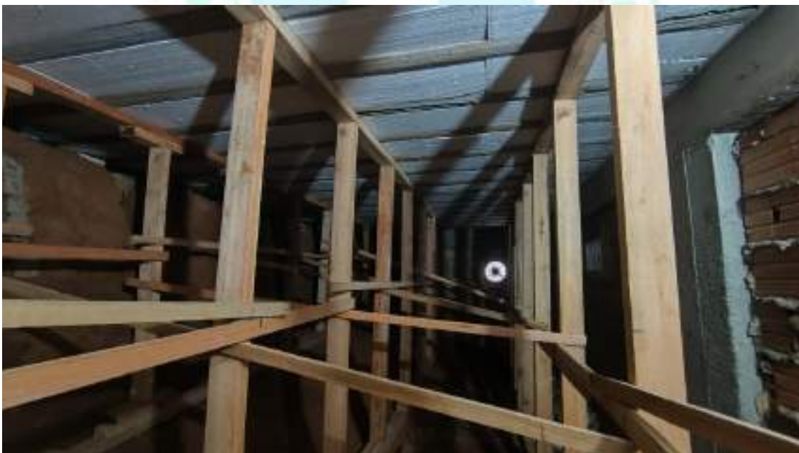
Figura 33 – Aberturas adicionadas para diminuição da umidade interna e escoramento da estrutura.
