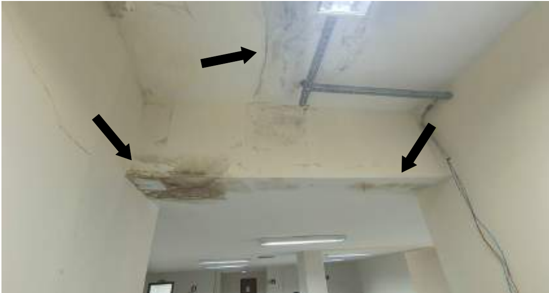
Figura 5 – Sinais de umidade no corredor, no pavimento inferior ao térreo.
