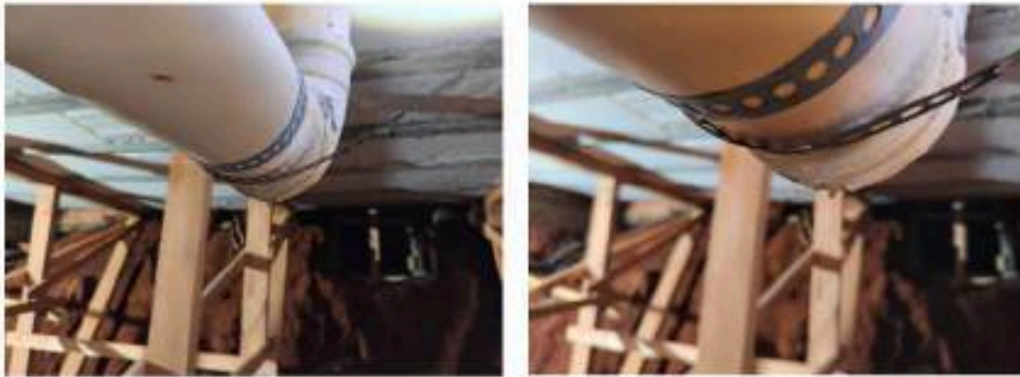
Imagem 3 e 4 (dia 06/02/2026): escoamento de água pela parte externa dos tubos. Fonte autor
