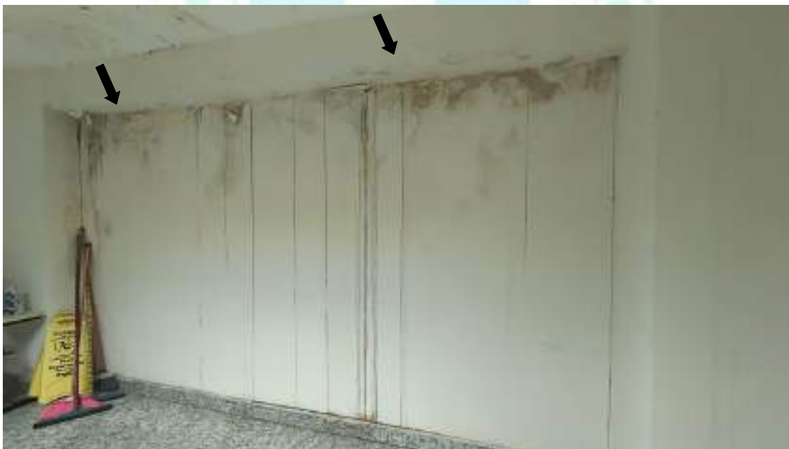
Figura 14 – Sinais de umidade nas partes superiores da parede, na Sala 2.
