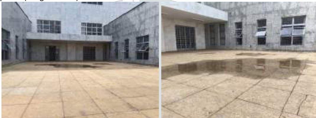
Imagem 1 e 2 (dia 05/11/2025): Empoçamento de águas pluviais L4A e L5A. Fonte autor
