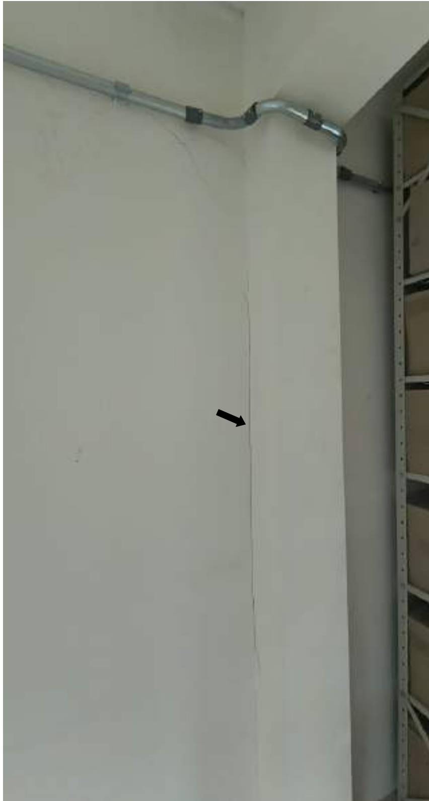
Figura 19 – Trinca na parede da Sala 2.
