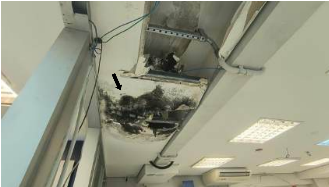
Figura 13 – Deterioração do gesso devido à umidade, na Sala 1.
