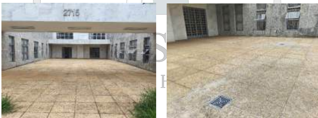
Imagem 1 e 2 (dia 07/01/2025): Sistema provisório captação água nas lajes L4A e L5A. Fonte autor
