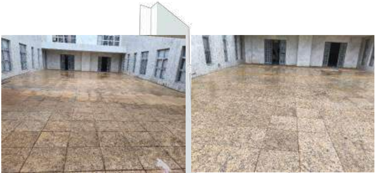
Imagem 1 e 2: Empoçamento de águas pluviais L4A e L5A. Fonte autor
