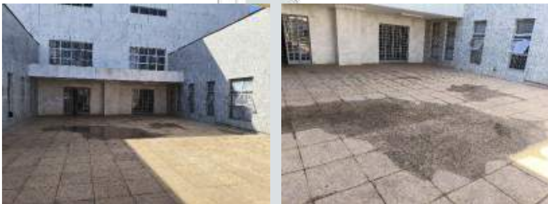
Imagem 1 e 2: Empoçamento de águas pluviais L4A e L5A. Fonte autor
