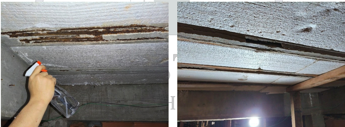
Imagens 19 e 20 As lajes L4A e L5A permanecem com histórico de infiltrações associadas à deficiência de drenagem, reforçando a necessidade de correção adequada do sistema de captação e vedação das tubulações instaladas: Exemplo Laje: L50. Fonte autor
