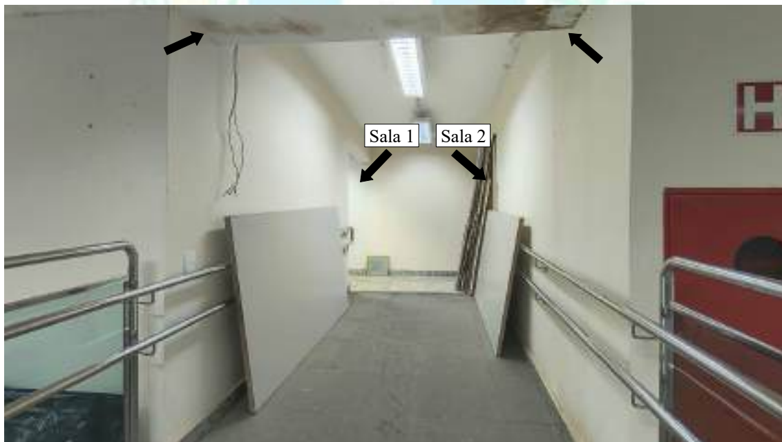
Figura 3 – Sinais de umidade em corredor no pavimento inferior ao térreo e localização das salas com presença de umidade.
