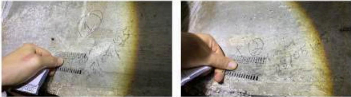
Imagens 9 e 10: Exemplo Viga: V58. Fonte autor
