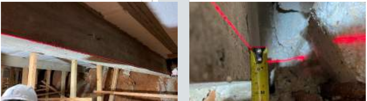
Imagens 5 e 6: Exemplo Viga: V46. Fonte autor
