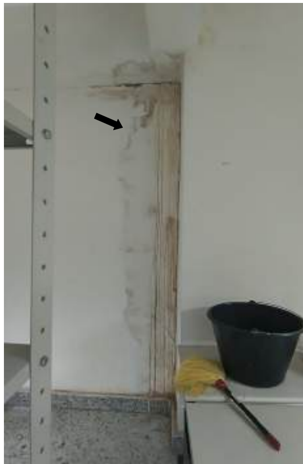
Figura 18 – Sinais de umidade na parede da Sala 2.
